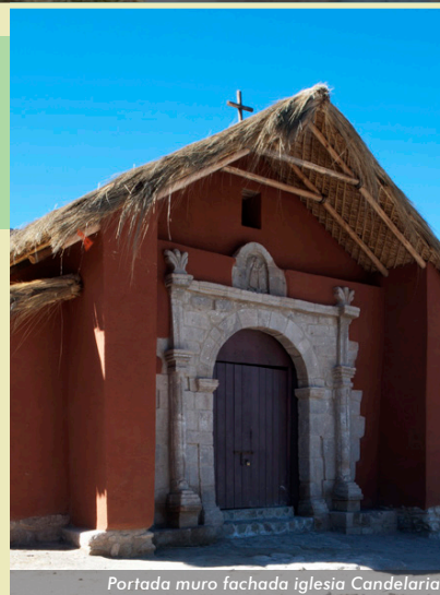
Portada muro fachada iglesia Candelaria.
