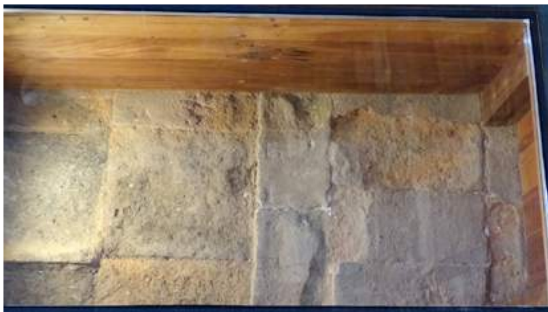
Fotografía que exhibe rasgos de ladrillos cocidos de un piso original enterrados a 40 cm de profundidad, los que se dejaron en exhibición en la nave central del templo.
