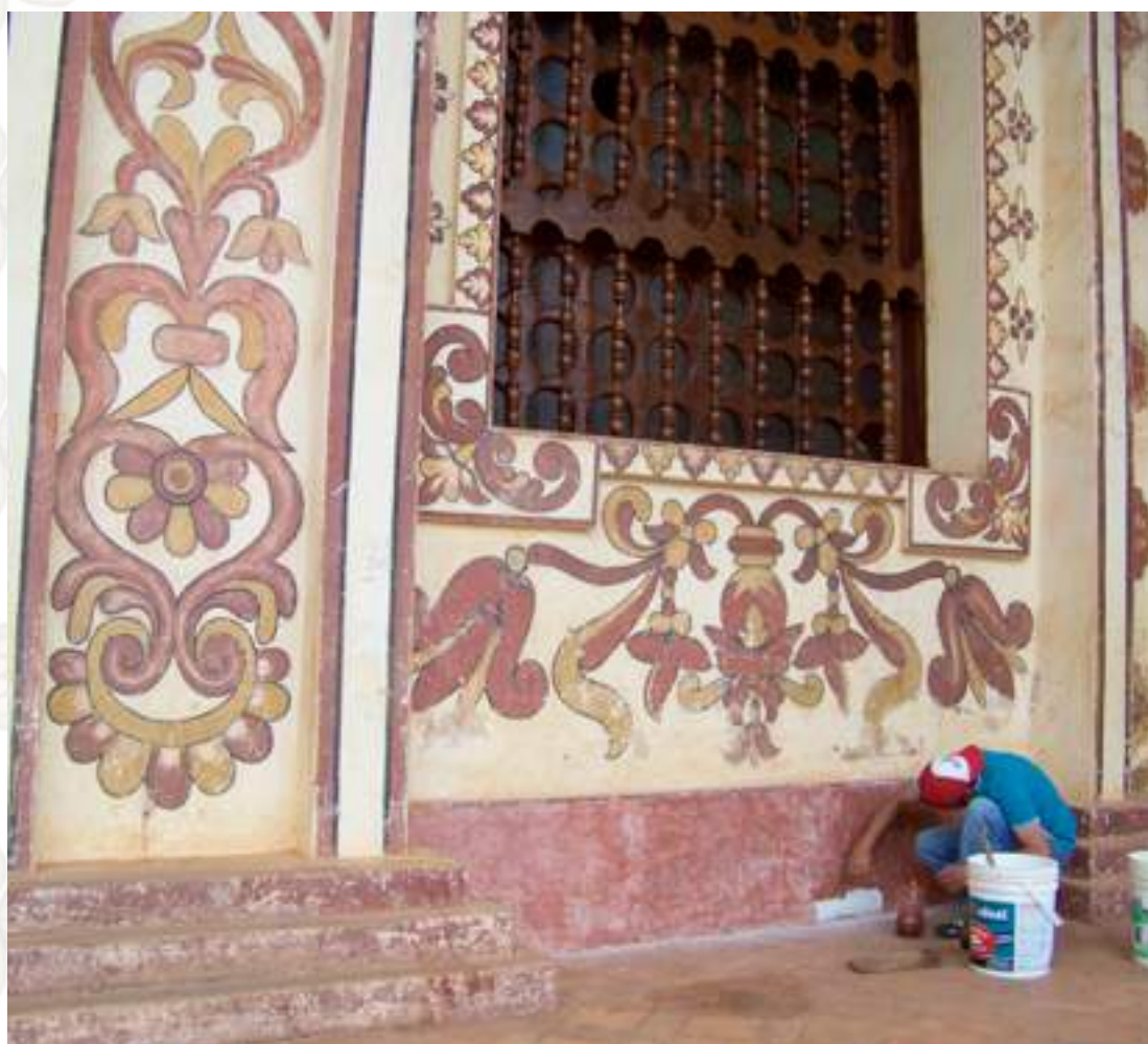
Trabajos de consolidación de pintura mural dentro del Plan de Mantenimiento de los conjuntos misionales
