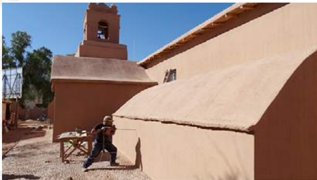
Detalle de la tarea de prospección de la “Cripta”.
