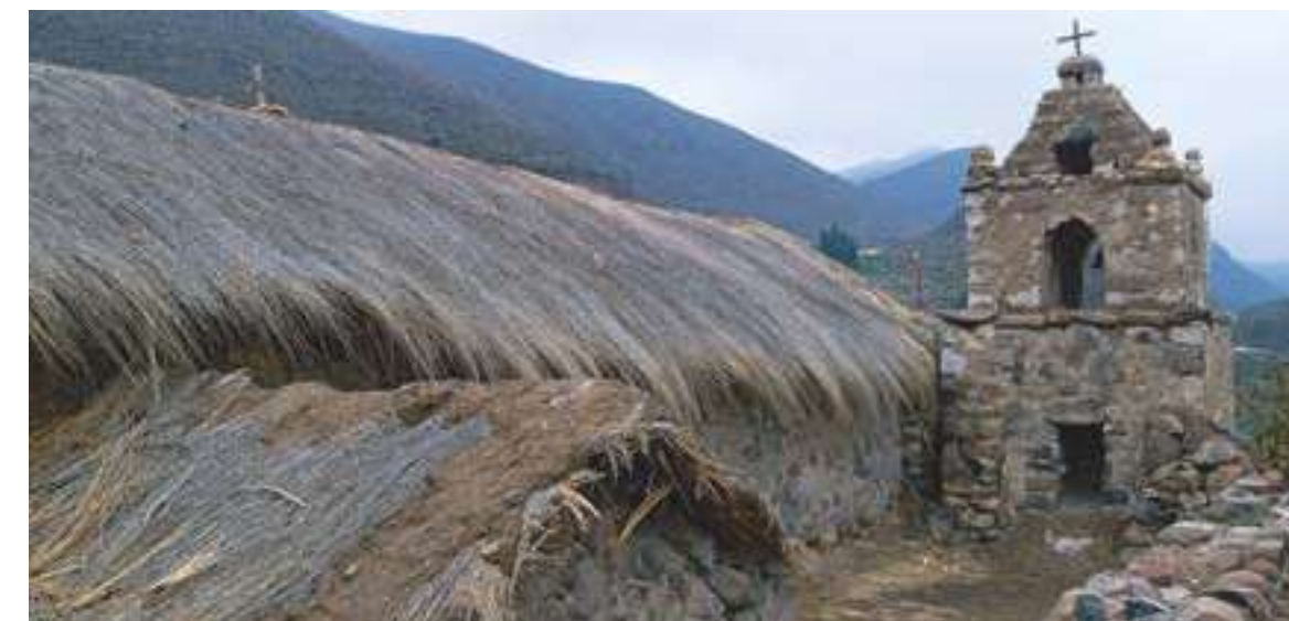
Iglesia de San Antonio de Sucuna, con muros construidos con piedras y mortero de tierra, s. XIX. Church of San Antonio de Sucuna, with walls built using stones and earth mortar, 19th c.
