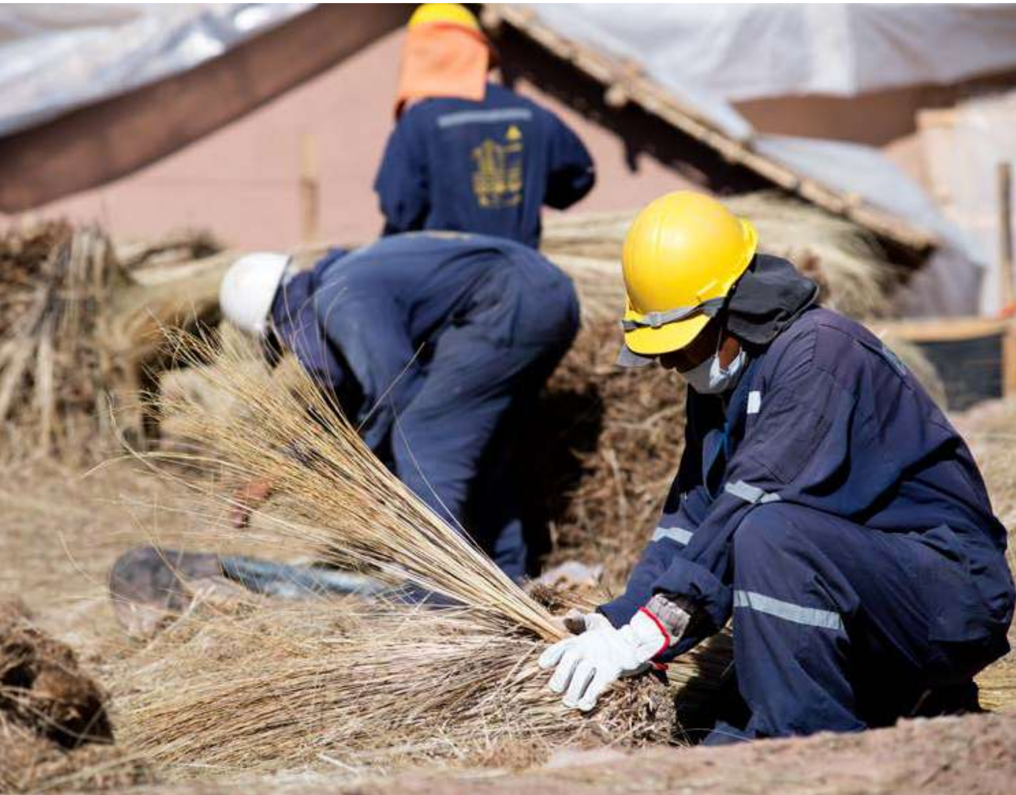
Trenzado de paja ichu para cubierta de techumbre. Ichu straw weaving for roofing.
