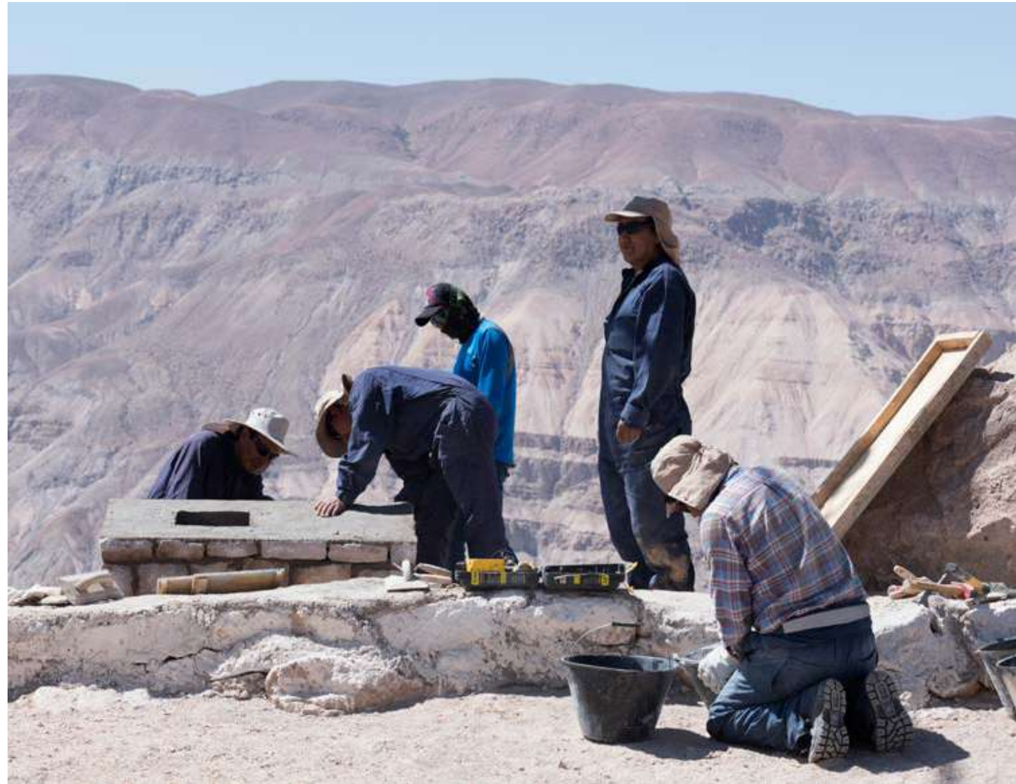
Instalación de señalética del templo de San José, en el pueblo de Pachica. Installation of church signs, St. Joseph church, Pachica village.
