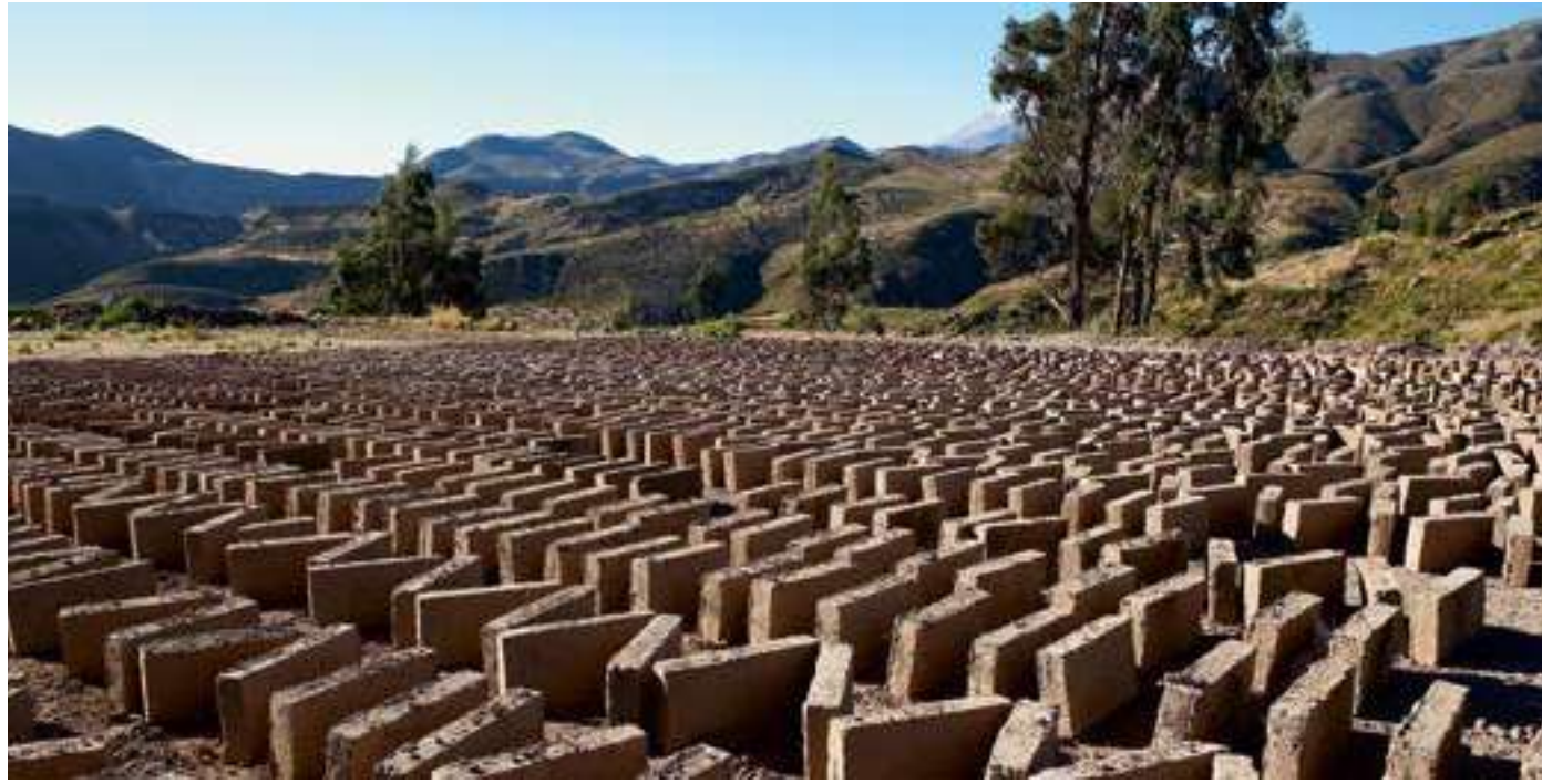
Adobes en proceso de secado para restauración de la iglesia de San Francisco de Asís de Socoroma. Adobes in the process of drying, to be used for restoration of the church of San Francisco de Asís de Socoroma.
